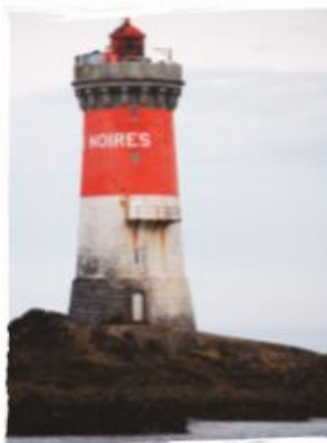
Au sud de l'Archipel de Molène, en mer d'Iroise... le Phare des Pierres noires.
